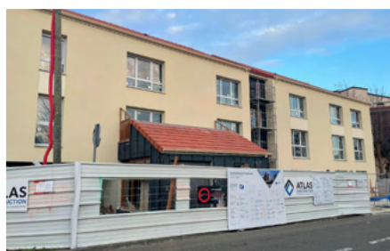
Construction d'une résidence pour personnes autonomes en situation de handicap
